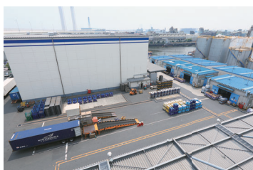
横浜化学品センター／築港の保管施設のなかで東日本最大の規模を誇り、2012年には新倉庫も増設しました。
