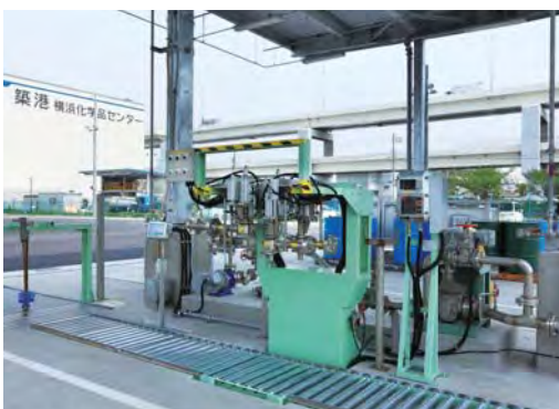
マルチワークステーションでは、ISOタンクコンテナ、ドラム缶、ローリーなどの各種詰め替え作業が可能です。
